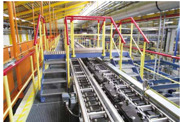
Montage Fördertechnik und Stahlbau Installation of conveyors and steel structures
